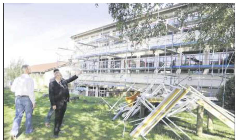
Bauleiter Peter Kübler, Baubürgermeister Andreas Stanicki und (im Hintergrund) Frank Fussenegger vom Amt für Gebäudemanagement beim Baustellenbesuch in der Reinhold-Maier-Schule. Bild: Bernhardt
